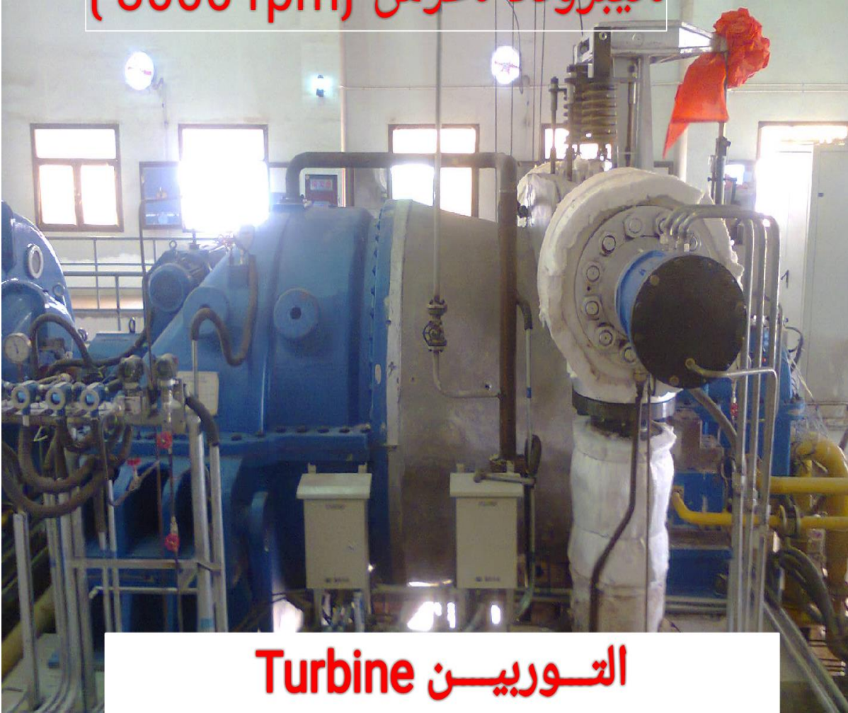
الشكل (3-3) يوضح التوربين البخاري للمحطة
