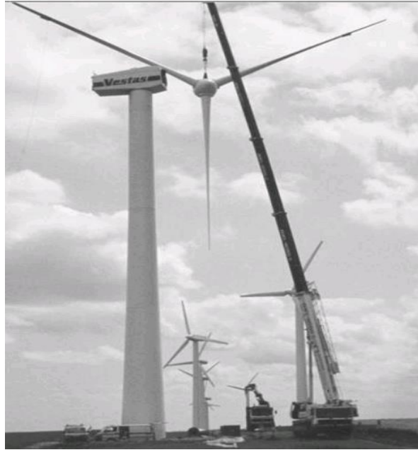
الشكل رقم (4-3): يوضح تجميع العنفات على الأرض ورفعها
