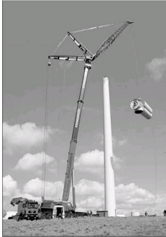
الشكل رقم (4-6) : يوضح رفع الناسيل إلى قمة البرج
