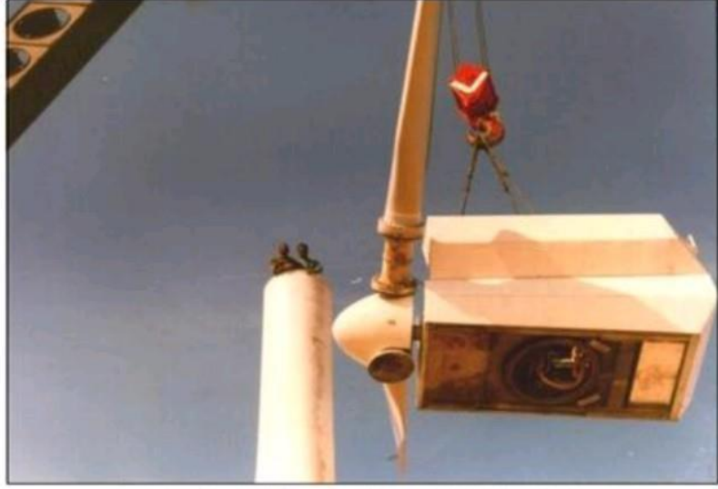
الشكل رقم (4-2): يوضح رفع الناسيل فوق البرج
