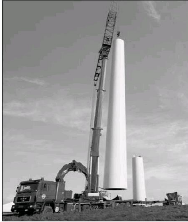
الشكل رقم (4-4) : يوضح رفع البرج لتركيبه على القاعدة
