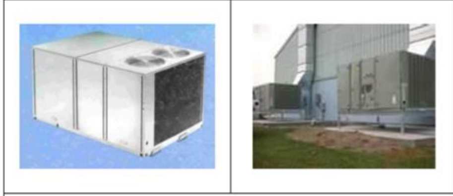
شكل (3-2) يوضح وحدات تكييف مجمعة
