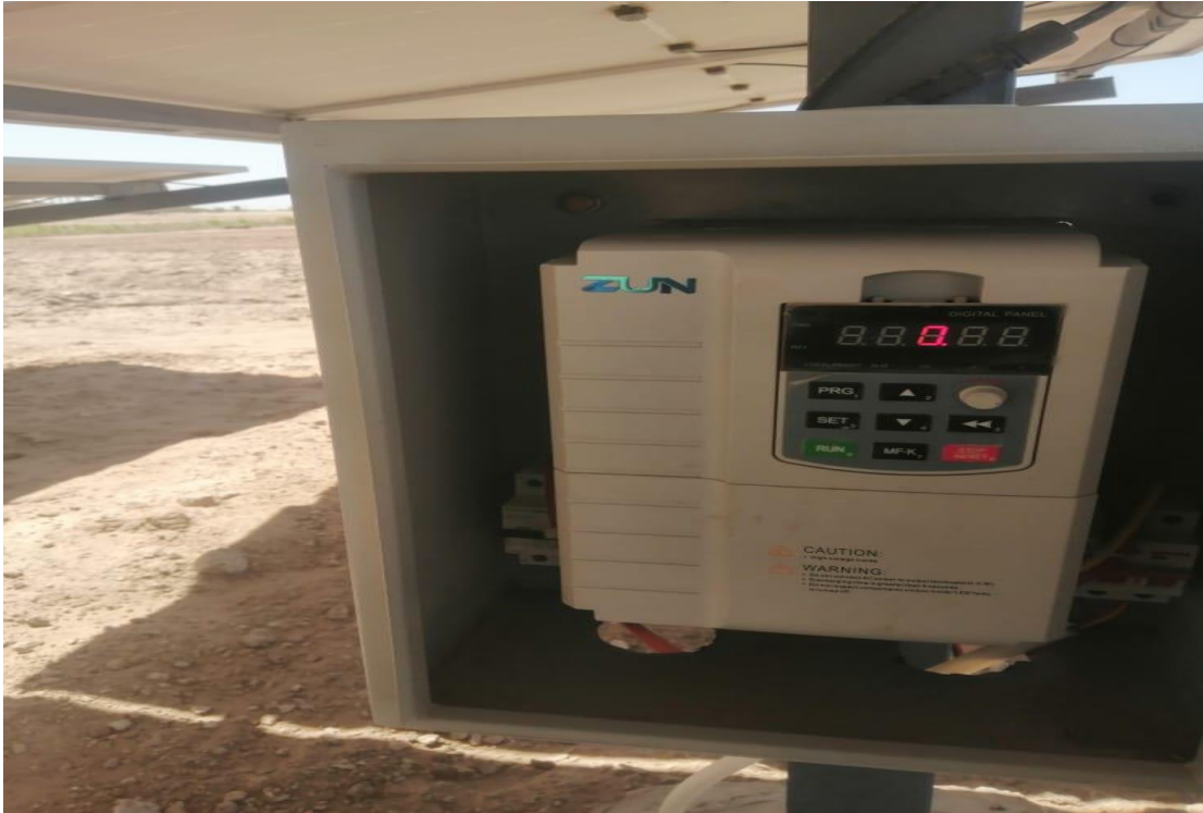
شكل رقم 3-9 يوضح ال Inverter
