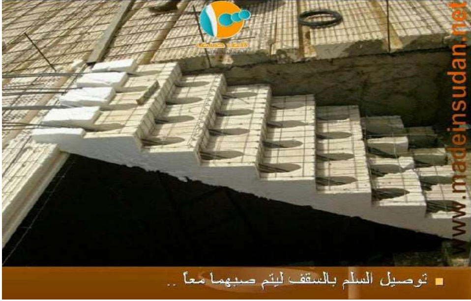
الصورة (2-14) توضح توصيل السلم بالسقف قبل صبهما
