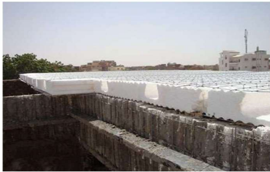
الصورة (2-5) توضح اللوح الارضي او لوح السقف
