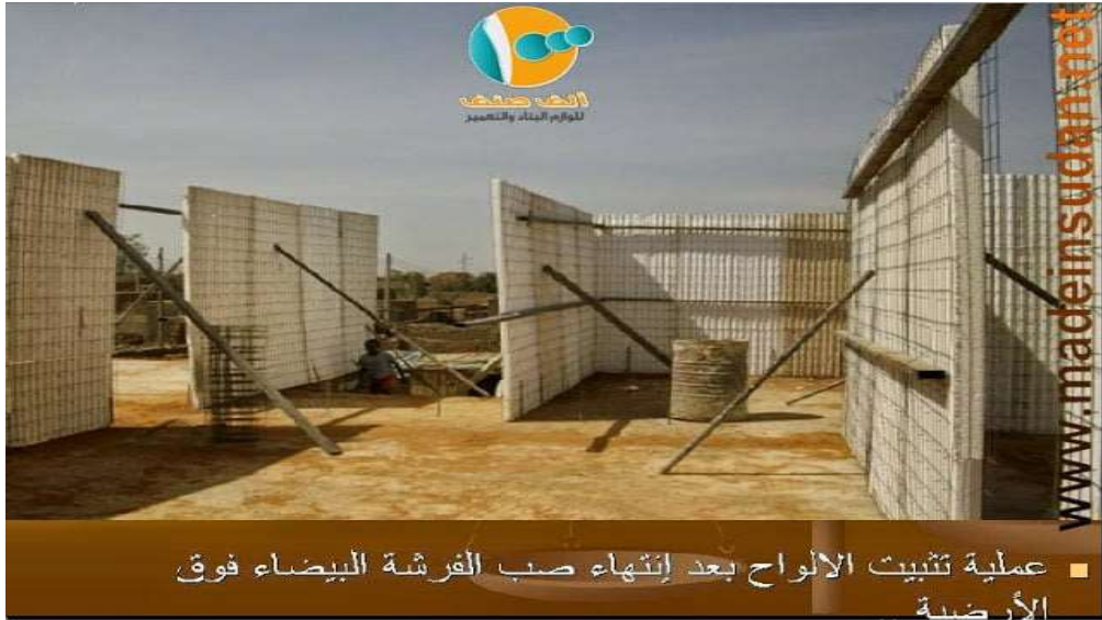
الصورة (10-2) توضح عملية تثبيت الألواح
