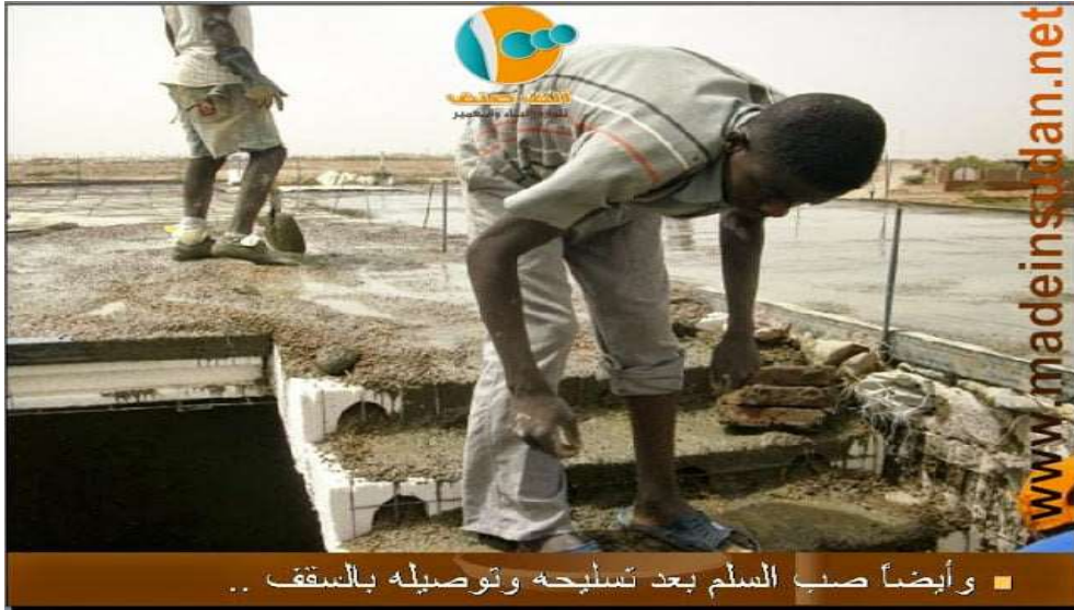
الصورة (2-14) توضح توصيل السلم بالسقف قبل صبهما
