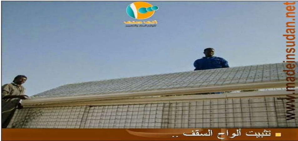
الصورة (11-2) توضح تثبيت ألواح السقف
