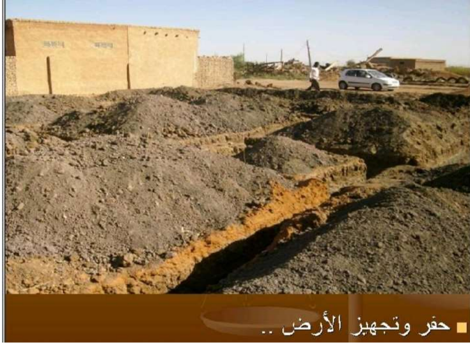
الصورة (2-7) توضح مرحلة حفر وتجهيز الارض
