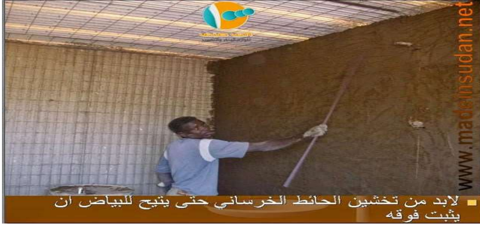
الصورة (2-16) توضح عملية تخشين الحائط الخرساني
