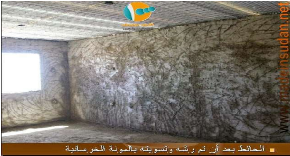
الصورة (2-16) توضح عملية تخشين الحائط الخرساني
