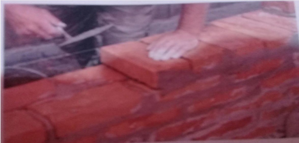
الشكل (2-4) يوضح البناء بالطوب الأحمر
