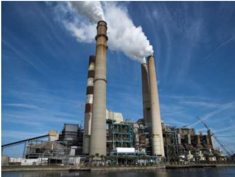
شكل(6-2) يوضح المدخنة في محطات التوليد البخارية
