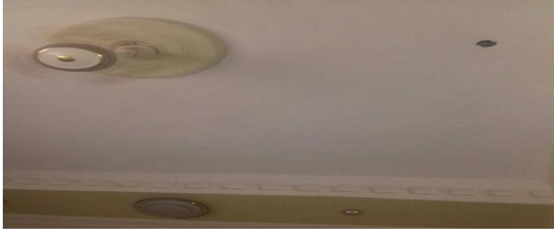
شكل (3 - 20): صورة توضح سقف خرساني-عطبرة الداخلة
