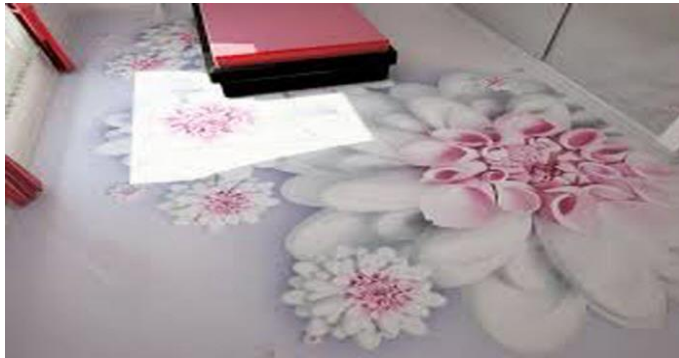
شكل (3 - 6): صورة توضح أرضية ايبوكسية- مدينة النسيم السكنية-الحاج يوسف
