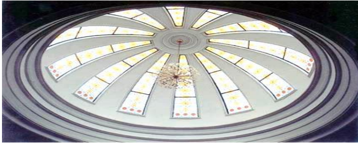
شكل (2 - 4): صورة توضح سقف مقبب
