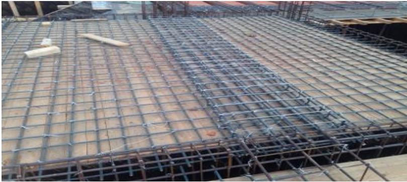
شكل (3 - 2): صورة توضح سقف الهوردي-أم درمان- ود نوباوي.
