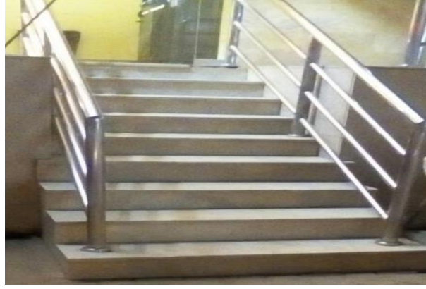
شكل (3 - 35): صورة توضح أرضية رخام-بنك النيل- ربك-حي السوق
