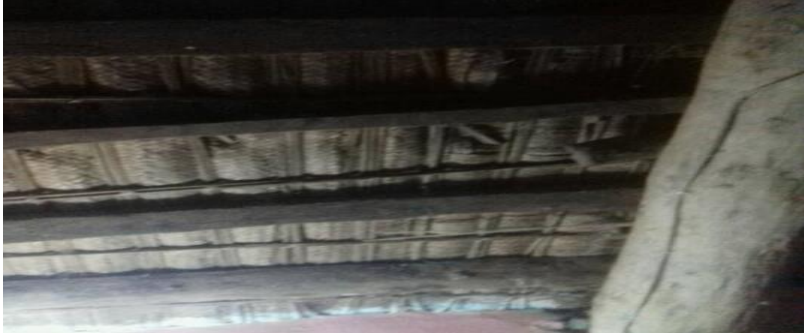
شكل (3- 21) صورة توضح سقف بلدي لمنزل - الشمالي - عطبرة
