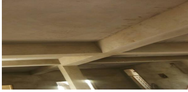
شكل (3-13) صورة توضح سقف خرساني - مجمع سكني - حي ديم مدينة-بورتسودان
