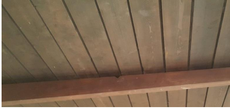
شكل (3 - 26): صورة توضح سقف خشبي - ود مدني - حي العمال
