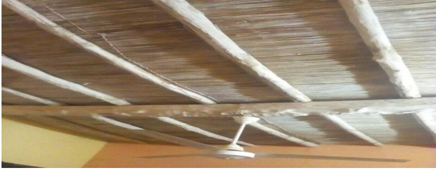
شكل (3 - 33): صورة توضح سقف بلدي - حي العائدين - ربك
