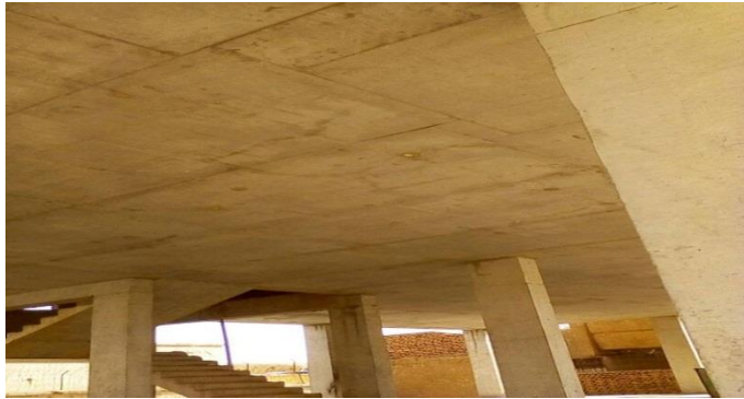
شكل (1-3) يوضح صورة سقف خرساني - عمارة أم درمان - الثورة الحارة 13.
