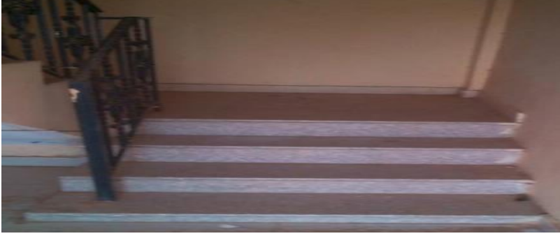
شكل (3- 43) صورة توضح أرضية رخام - شقق حي الصفا م2
