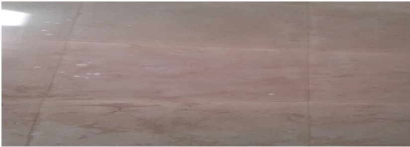
شكل (3- 44) صورة توضح أرضية بورسلين - شقق حي الصفا م2
