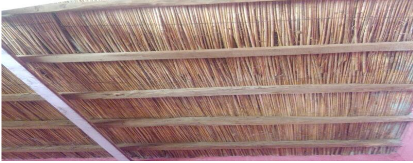
شكل (3-28) صورة توضح سقف بلدي - ود مدني مارنجان م2
