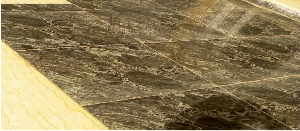
شكل (3 - 8): صورة توضح أرضية بورسلين-أم درمان -مكة للعيون- حي العمدة
