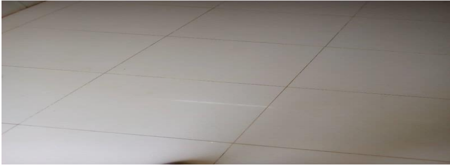
شكل (3-17) صورة توضح أرضية سيراميك شركة simens للتحويلات الحرارية- بورتسودان
