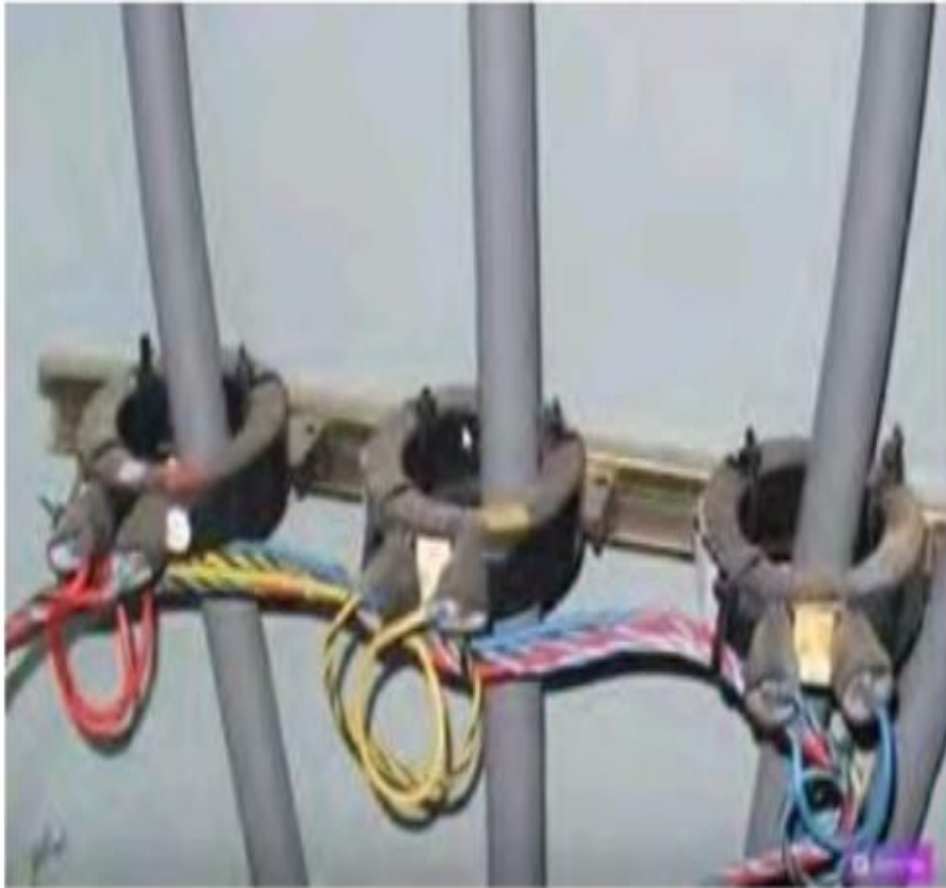
الشكل (3-2) محول تيار من نوع window Type
