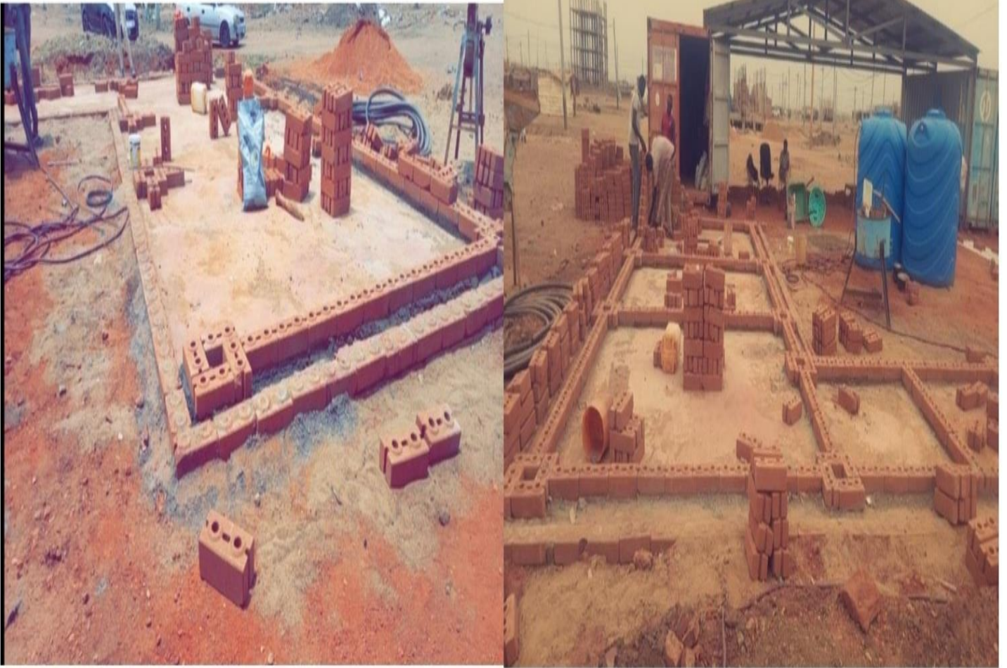
الشكل(3-10) يوضح عمل المدماك الاول مع استخدام مونة اسمنتية
