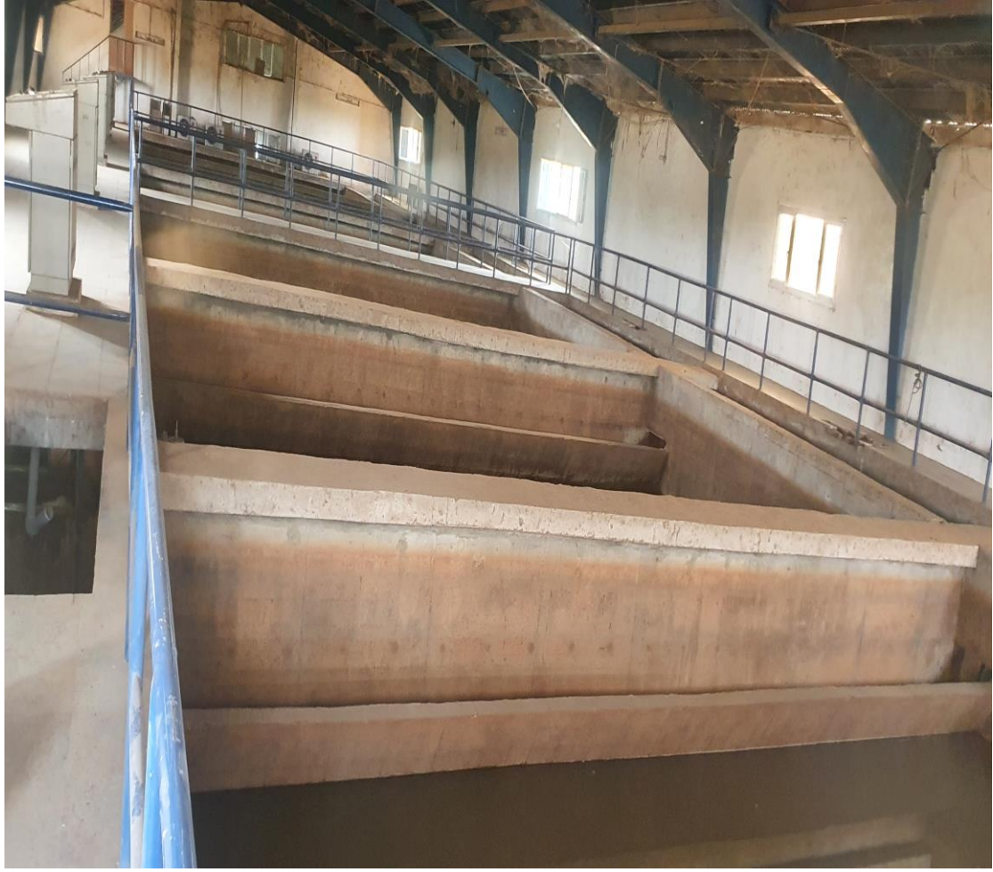
ملحق (G) يوضح احواض الترشيح بمحطة المقرن الجديدة (الدامر)
