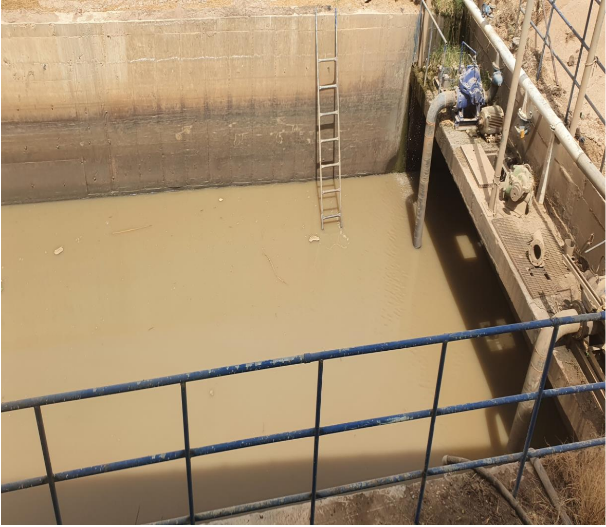
ملحق (ل) يوضح حوض لتجميع مياه غسيل المرشحات واحواض الترسيب بمحطة المقرن الجديدة (الدامر)
