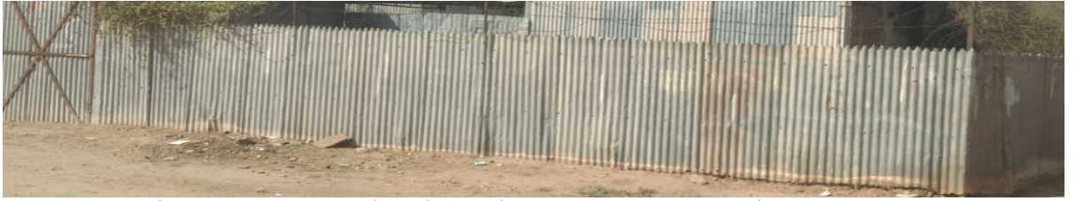
شكل (36-3) يوضح نموذج لحائط الزنكالمستخدمة في مباني السكة حديد
