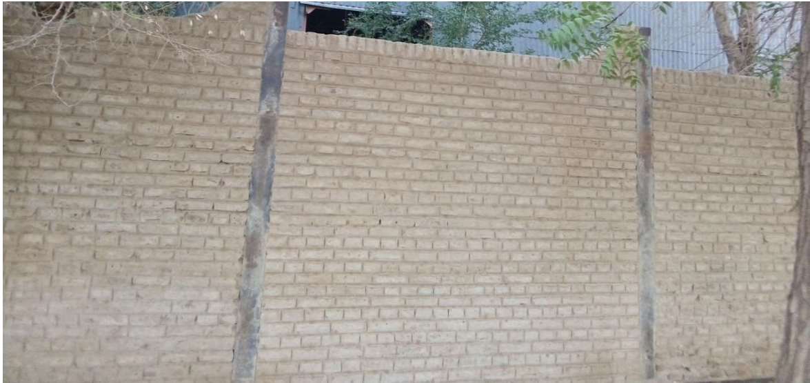
شكل (3-35) يوضح نموذج لحائط الطوب المستخدمة في مباني السكة حديد
