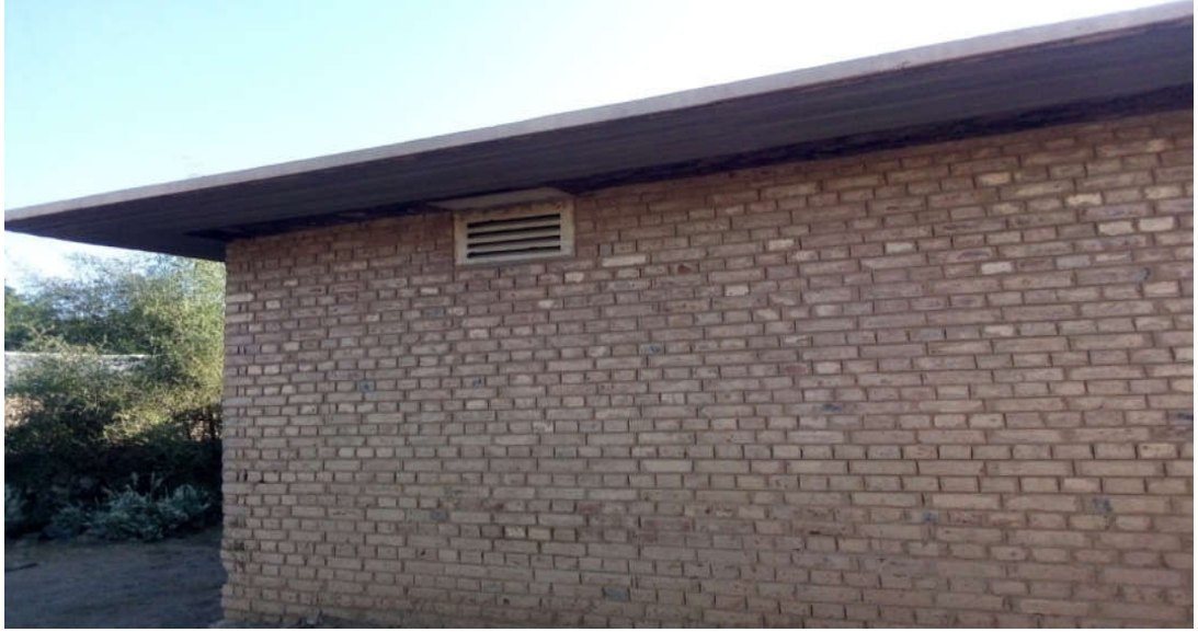
شكل (3-34) يوضح نموذج لحائط الطوب المستخدمة في مباني السكة حديد
