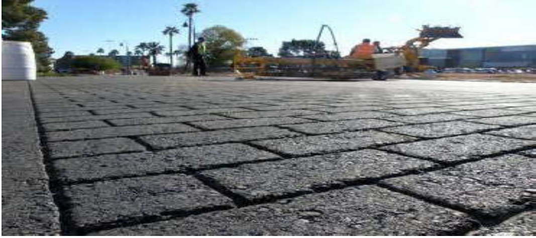
شكل (2-16) يوضح الطوب الأسفلتي
