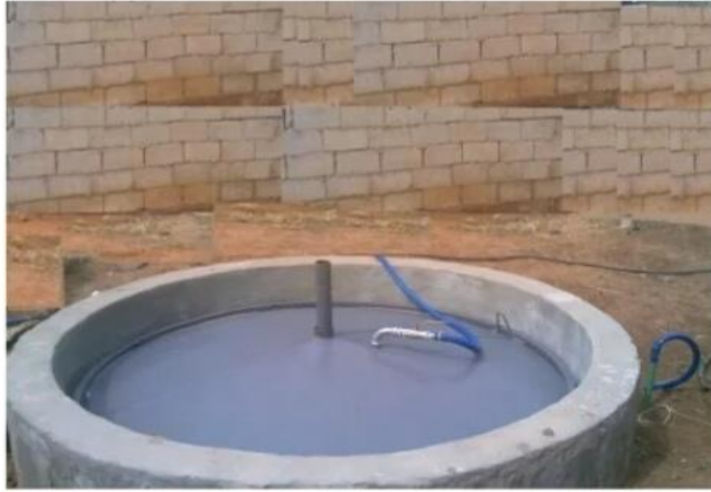
الشكل (11-2) تثبيت خزان الغاز على المحور
