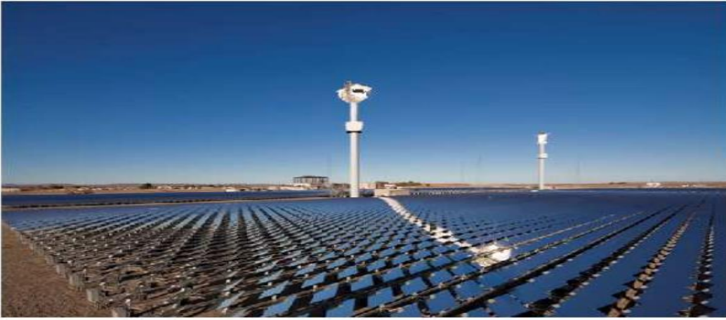
الشكل 3.3 يوضح تقنية البرج المركزي
