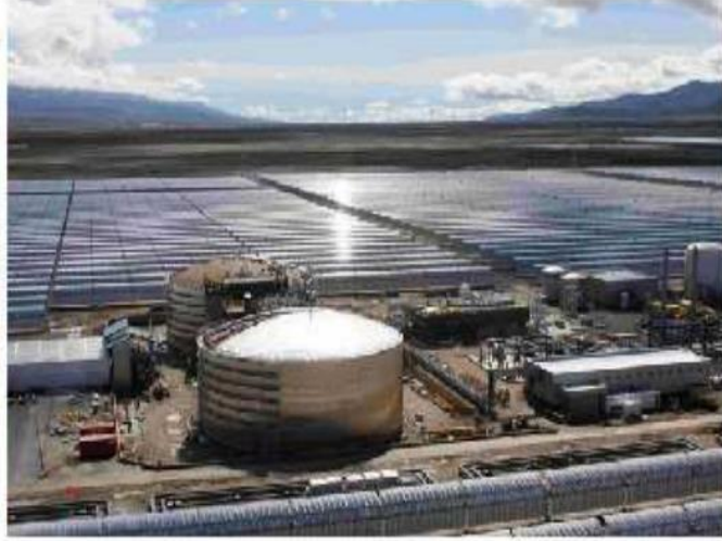
الشكل 2.3 يوضح تقنية المراكز الشمسية ذات القطع المكافئ الاسطواناني
