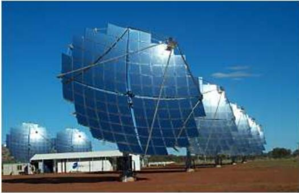
الشكل 1.3 يوضح تقنية المركزات الشمسية ذات القطع المكافئ الدائري
