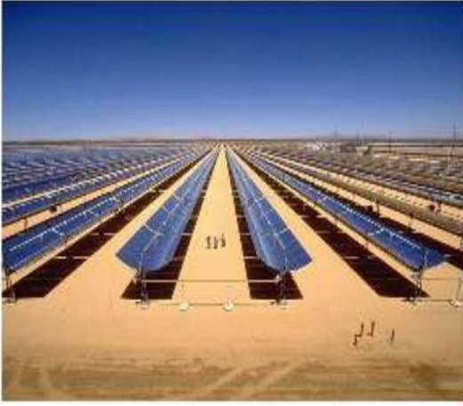
الشكل 2.3 يوضح تقنية المراكز الشمسية ذات القطع المكافئ الاسطواناني
