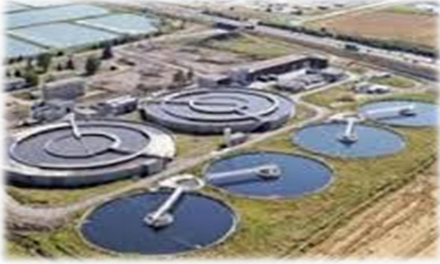
شكل يوضح خزانات أرضية
