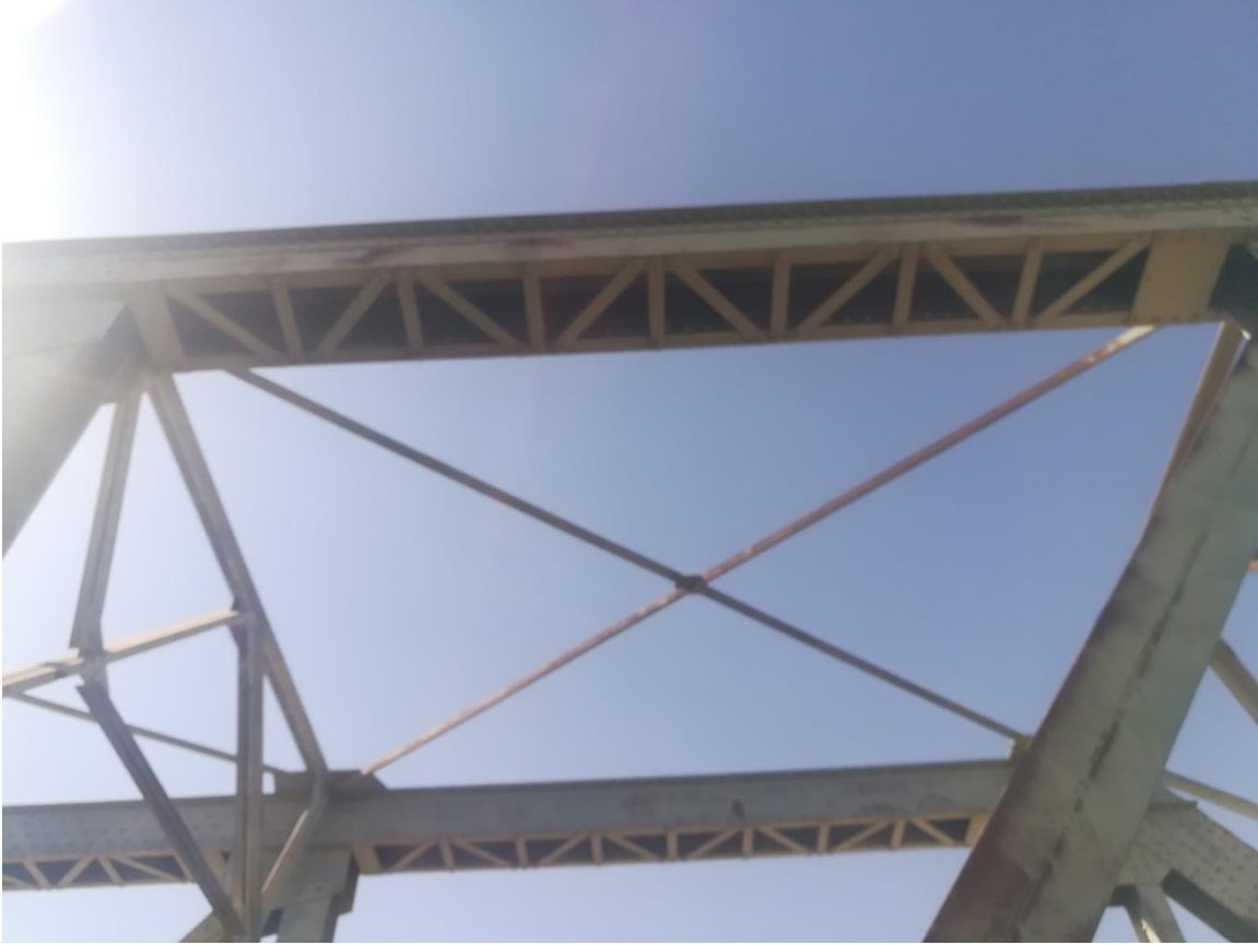
شكل(3-6) يوضح الشدادات العلوية فى الكبرى
