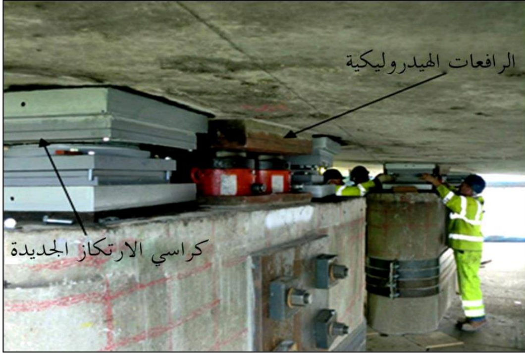
الشكل (2-12) يوضح عملية استبدال كراسي الارتكاز
