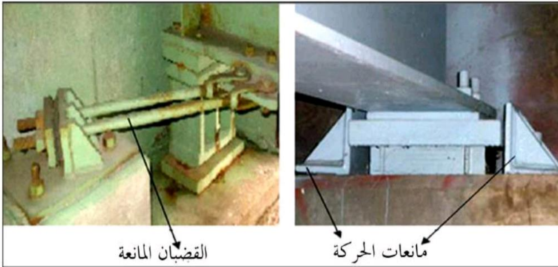
الشكل (2-9) يوضح الإصلاح والتحديث باستخدام القضبان المانعة ومانعات الحركة
