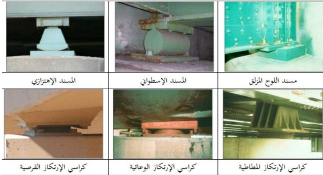
شكل(2-4) يوضح أنواع المساند أو كراسي الارتكاز
