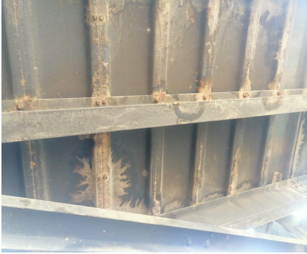
شكل (1-3) يوضح الصدأ في الاجزاء السفلية للكبرى
