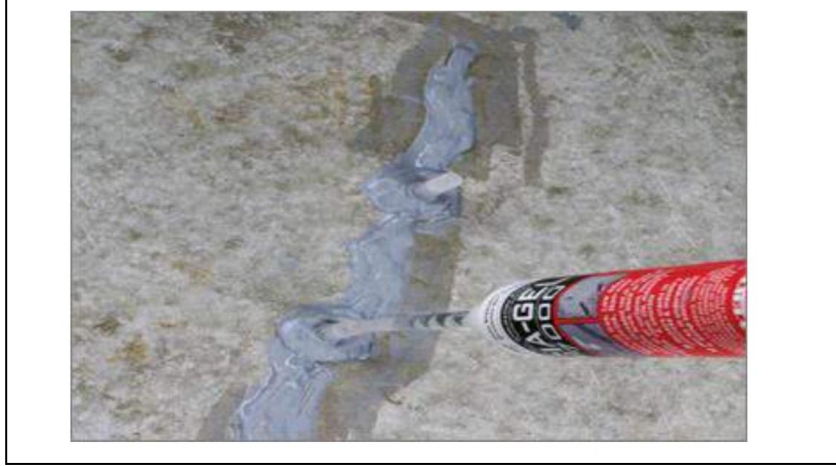
الشكل (2-13) يوضح الحقن عن طريق الايبوسكى
